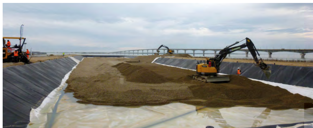
Lagune de traitement des sédiments en cours de finition sur le site de La Repentie
